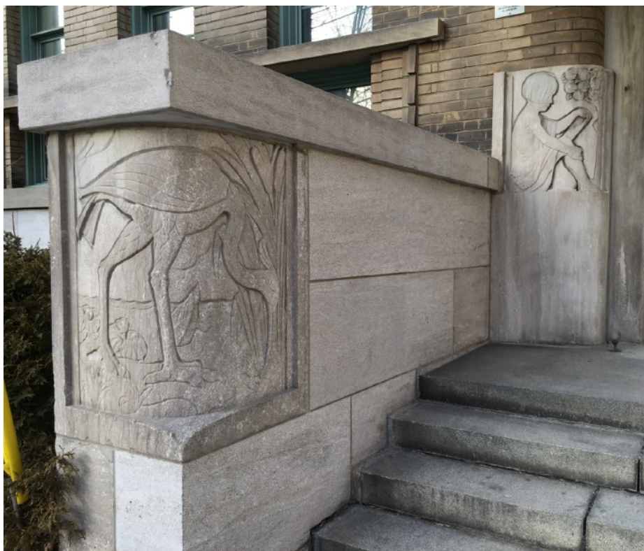
Détail des bas-reliefs à gauche de l'entrée principale / photo Justin Bur 2016
