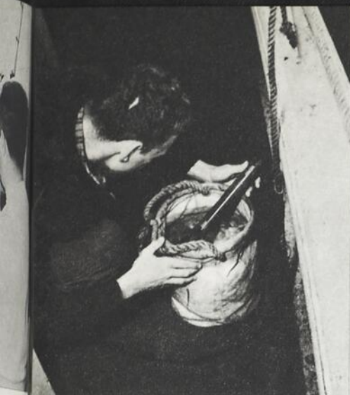
Mesure de la température de l'eau de surface avec un thermomètre de précision.
