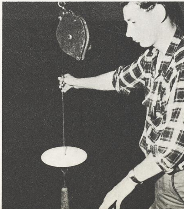
Envoi d'un disque Secchi pour mesurer la transparence de l'eau.
