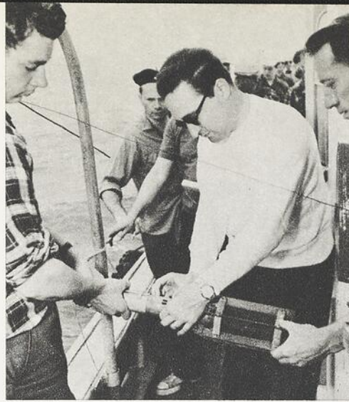
La lame de verre enduit de fumée sur laquelle s'est inscrite la courbe de la température est extraite de l'appareil.
