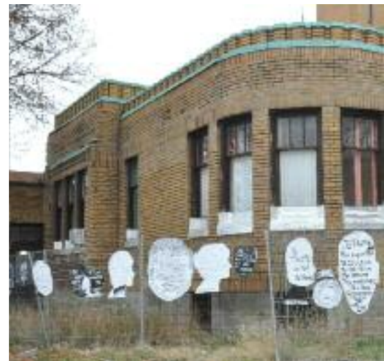
L'état actuel du bâtiment de l'ancienne clinique d'inspection des viandes.
