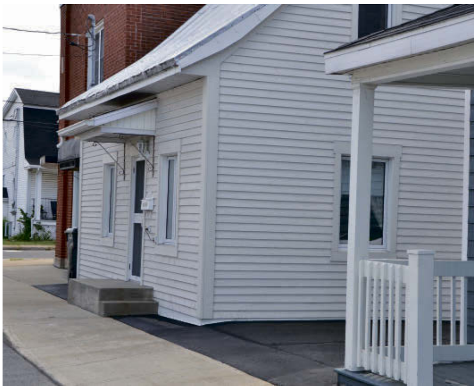
Plusieurs maisons patrimoniales ont été rénovées au centre-ville de Sorel-Tracy.
