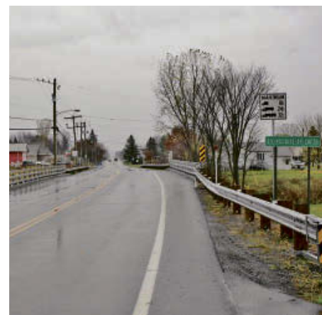
Le pont situé sur la route 239 à Sainte-Victoire-de-Sorel sera réparé cet automne et un détour est en vigueur.
