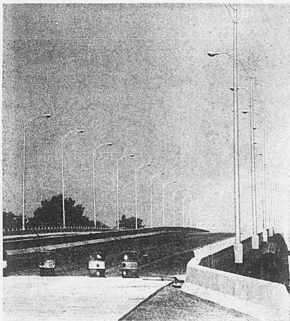
Comme on peut le constater, le pont de l'autoroute 13 au-dessus de la rivière des Prairies est presque terminé. Ce pont, d'une longueur de 1,695 pieds, contient 3,554 tonnes d'acier.
