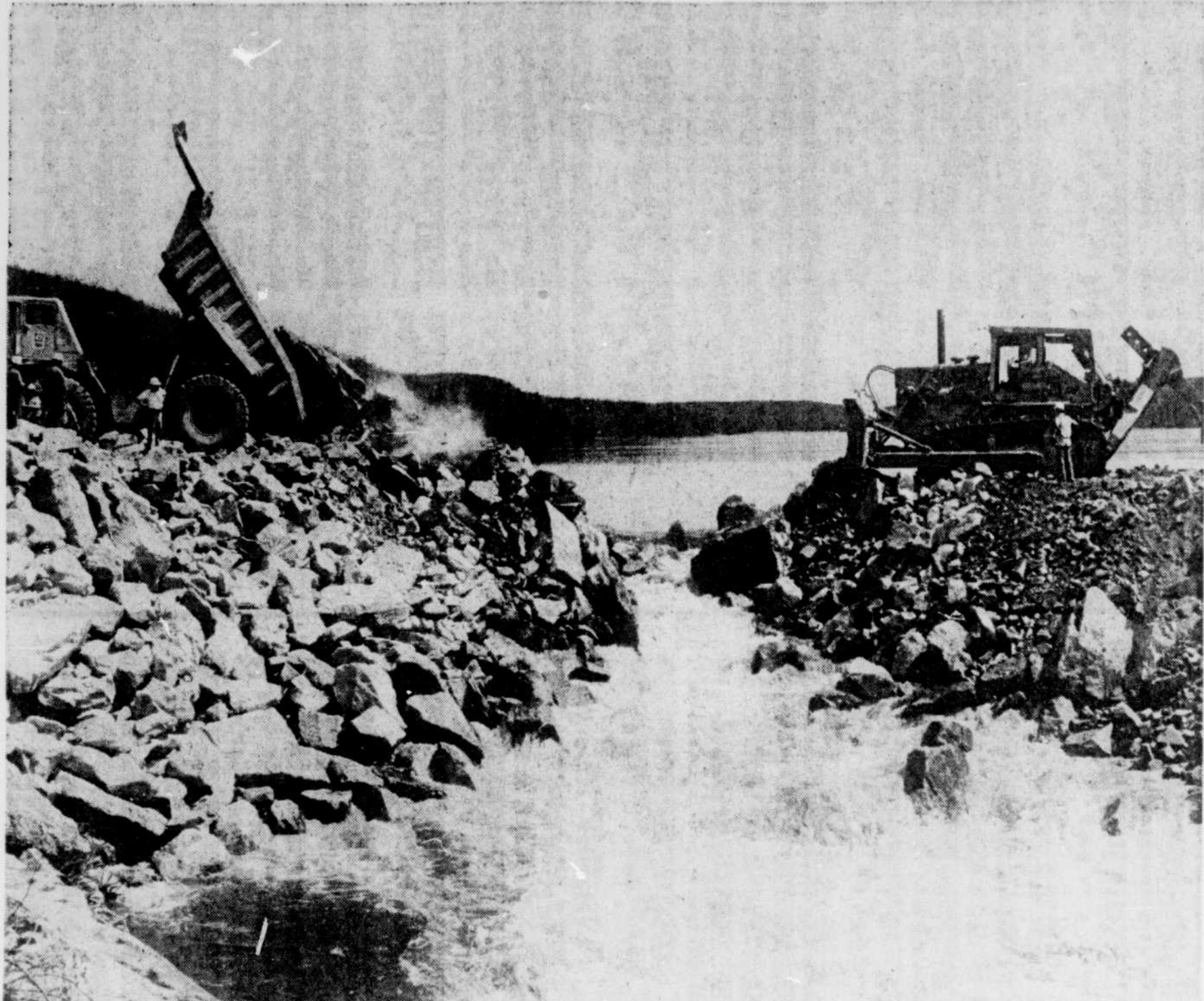
Lors de l'ouverture des galeries de dérivation de LG2, la fermeture du batardeau d'amont était un moment critique, nécessitant la mise en place de cailloux atteignant six pieds de diamètre pour boucher le dernier filet de la rivière La Grande.
