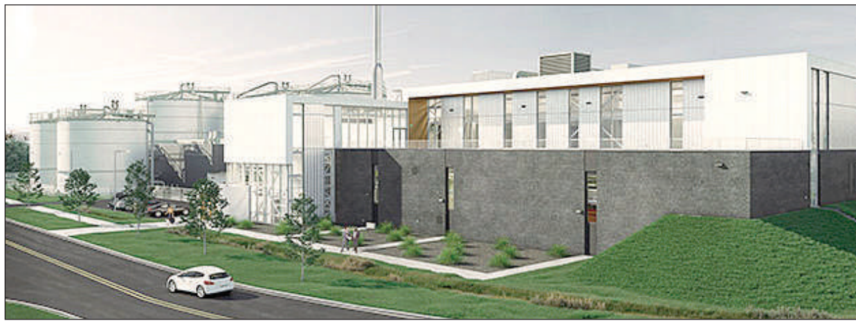
Le Centre de biométhanisation de l'agglomération de Québec.
