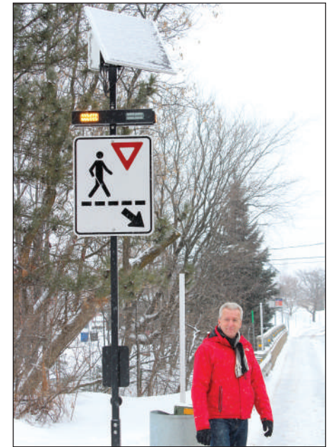
L'installation de feux rectangulaires à clignotement rapide, une traverse de piétons lumineuse qui vise notamment à céder le passage aux piétons, est déjà amorcée.
