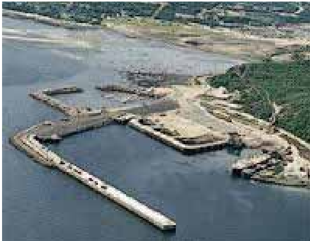
Figure 13 Port de Baie-Comeau et marina (Source : Ville de Baie-Comeau)
