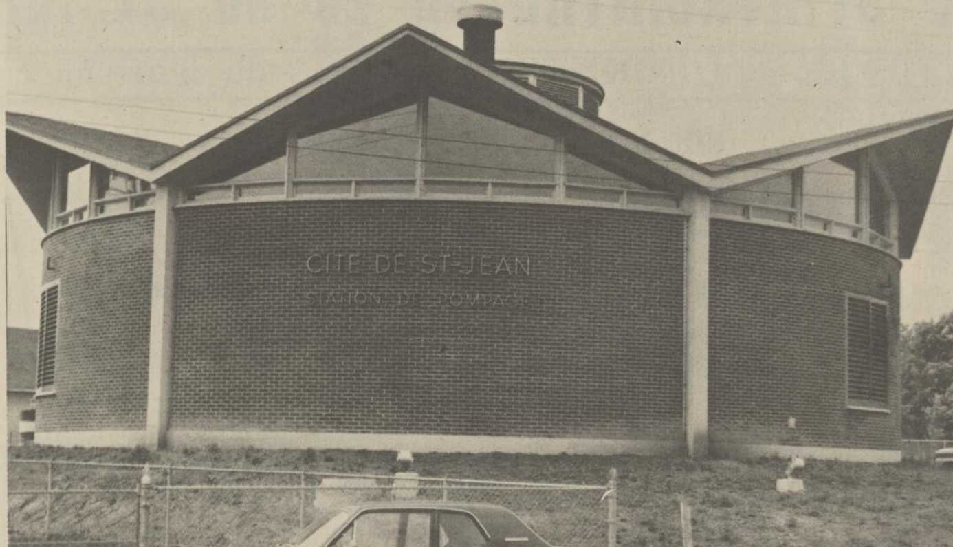
L'USINE DE POMPAGE de la cité de St-Jean est entièrement terminée. Déjà, tout l'équipement à l'intérieur de cette station de pompage est en fonction sous la direction
