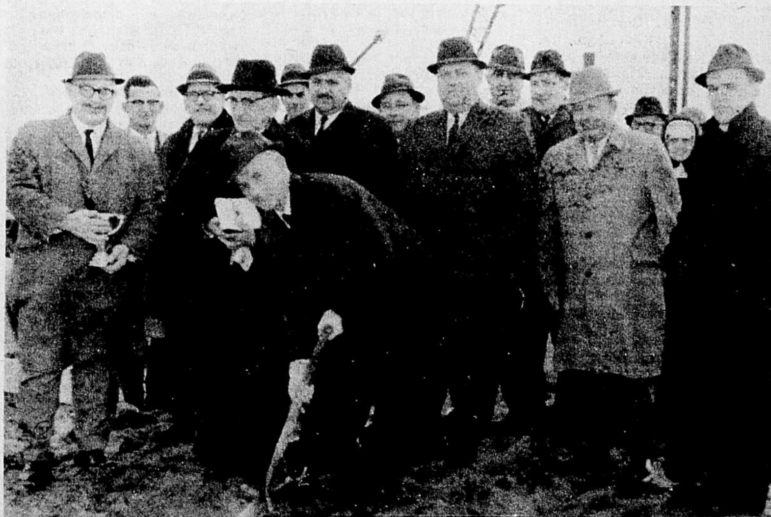
1ÈRE PELLETÉE OFFICIELLE. — Lundi dernier, avait lieu sur le site de la future école de Notre-Dame des Prairies, la levée de la première pelletée de terre, marquant le début des travaux. On voit, en avant, le Commissaire Poirier posant le geste officiel à titre de représentant de ce secteur au sein de la Commission Scolaire de Joliette. Dans le groupe, on remarque M. le curé Rondeau qui a béni les lieux et les travaux en marche; Me Claude-Edouard Héту, le dévoué président de la Commission Scolaire de Joliette et de la Régionale; M. l'échevin Bernard Malo, entrepreneur, qui a la construction de la dite école; M. l'échevin René Chaput; S.H. le maire Amable Chalut, de N.-D. des Prairies; M. Albert Nicoletti; M. le commissaire Montambault, M. R. Rochon et M. l'abbé Guy Chevette.
