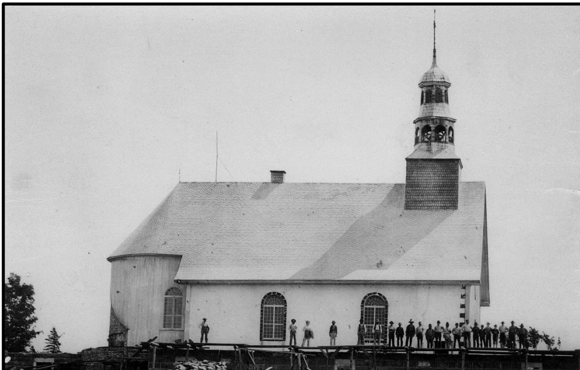
Figure 11 : La reconstruction de l'église de Sainte-Foy après son incendie en 1876. À noter : les nouvelles fondations sont érigées autour de l'ancien bâtiment. ( Sainte-Foy – Route de l'église – Église Notre-Dame-de-Foy – Édifice religieux , William Nottman, août 1876, BAnQ, P600, S6, D2, P61)
