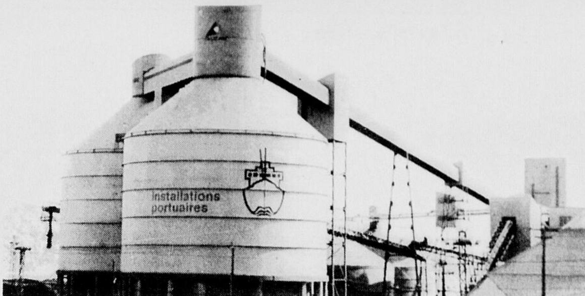
ALUMINE - Alcan disposait jusqu'à maintenant de ces deux silos pour emmagasiner l'alumine provenant d'Irlande et de la Jamaïque.
