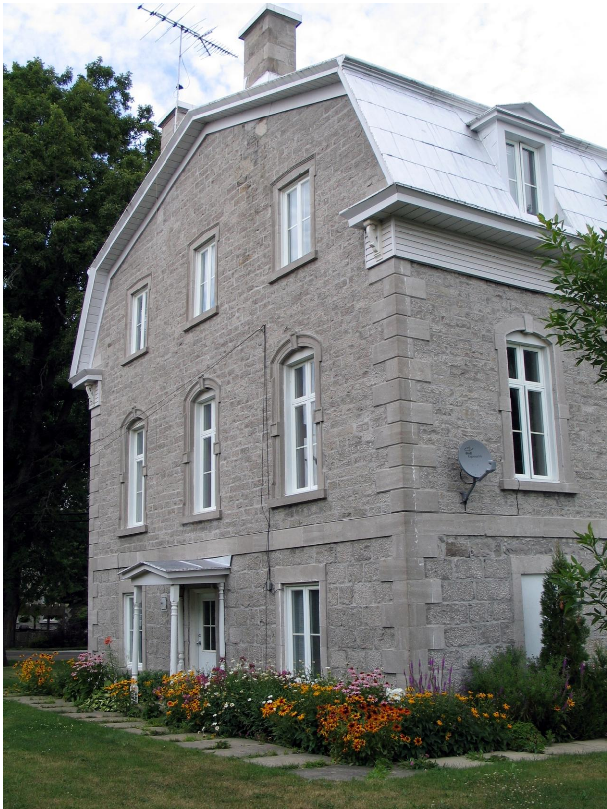
Entrée du côté de l'église.
