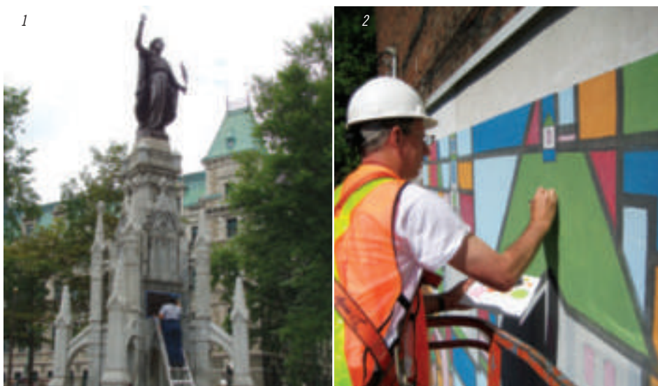
1 Application d'enduits protecteurs sur la statue du monument de la foi, à Québec et sur les plaques commémoratives. Photo : CCQ
