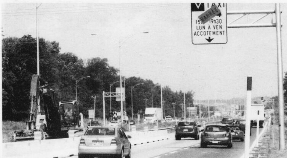
Déjà, depuis quelques jours, les usagers de la route en provenance de Montréal ont retrouvé la deuxième voie à laquelle ils avaient droit avant l'ouverture du pont A25. (Photo: Étienne Ferron-Forget)
