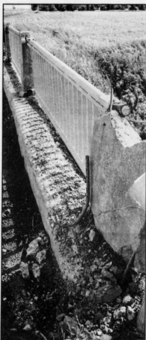
Comme on le voit ici, les parapets du pont sont maintenus en place avec de la broche!
