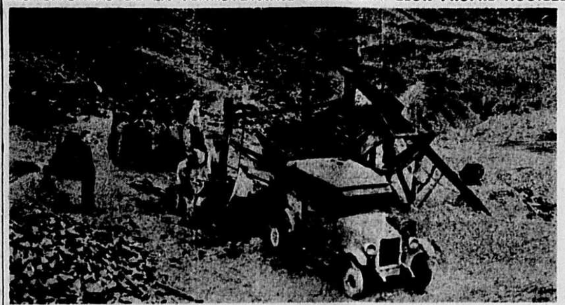
Des milliers de mines de charbon clandestines, en Pennsylvanie, sont actuellement équipées de cette façon avec un équipement de fortune qu'on fait descendre et monter dans un puits en utilisant comme force motrice l'essieu d'une petite voiture automobile. Les compagnies de charbon anthracite de Pennsylvanie prétendent que ces petites mines exploitent illégalement sur leurs vastes territoires leur dérobent chaque année de 3 à 4 millions de tonnes de houille. 20,000 hommes, prétend-on, sont employés à l'extraction du charbon de cette façon.
