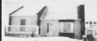
CHICOUTIMI: 1463, du Portage. Domaine du Roi, 4 chambres, rénovation au complet, remise, entrée pavée. A voir. Livraison rapide.
