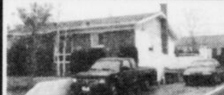
CHICOUTIMI-NORD: 134, rue Gouin, rénovation, sous-sol fini, abri d'auto, remise isolée. A voir.
