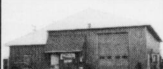
CHICOUTIMI: 175, de la Grande. Entrepôt avec 2 portes. Bureau. A voir. Livraison rapide.
