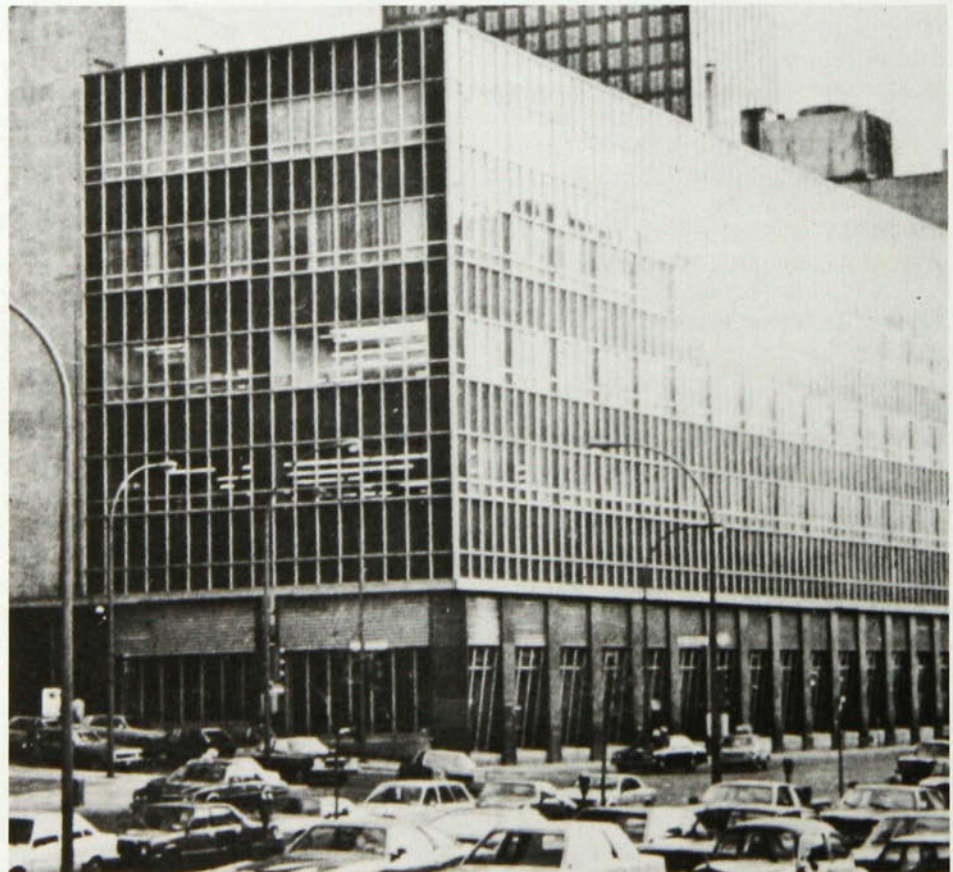
L'édifice moderne qui s'est juxtaposé en 1959. (Photothèque La Presse )
