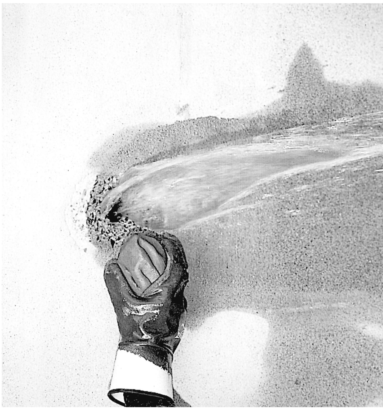
Pour de petites surfaces, le ciment polymère vendu chez les marchands de matériaux se révèle très efficace.
