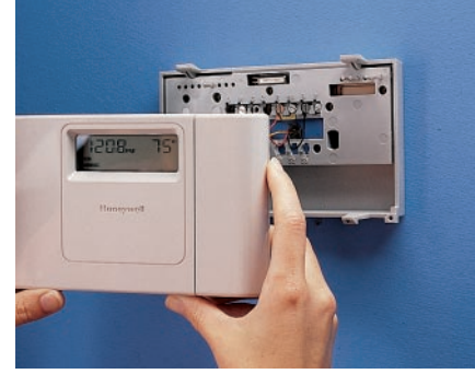
I. Connectez les fils à basse tension aux bonnes bornes; remettez le couvercle.
