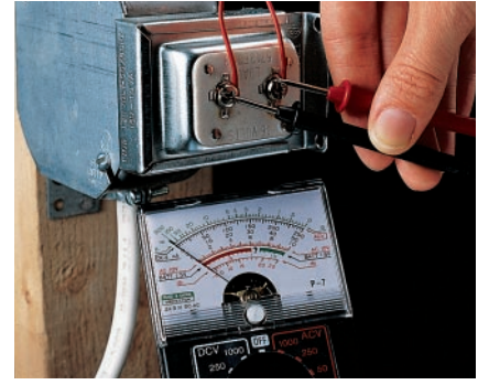
F. Avec un multimètre, vérifiez si le thermostat à basse tension fonctionne bien.
