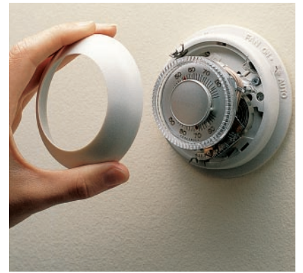
A. Le thermostat à basse tension, rarement défectueux, doit être inspecté toutes les saisons (poussière et fils lâches).
