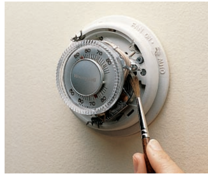
D. Retirez le couvercle; inspectez la spirale, les contacts et les connexions.
