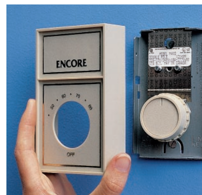
B. Le thermostat à tension secteur fonctionne à 120 V ou à 240 V. Avant de le réparer, coupez le courant au tableau de distribution principal.
