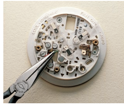
E. À l'aide d'une pince à bec effilé, enroulez les fils détachés autour des bornes, puis vissez ces dernières.
