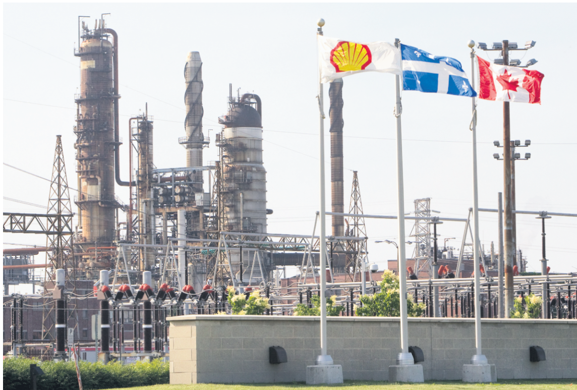
PHOTO ROBERT SKINNER, ARCHIVES LA PRESSE Selon des informations jamais confirmées par Shell, la pétrolière a dépensé entre 100 et 200 millions de dollars pour démanteler et décontaminer la raffinerie, qui a fonctionné de mars 1933 au 7 octobre 2010.
