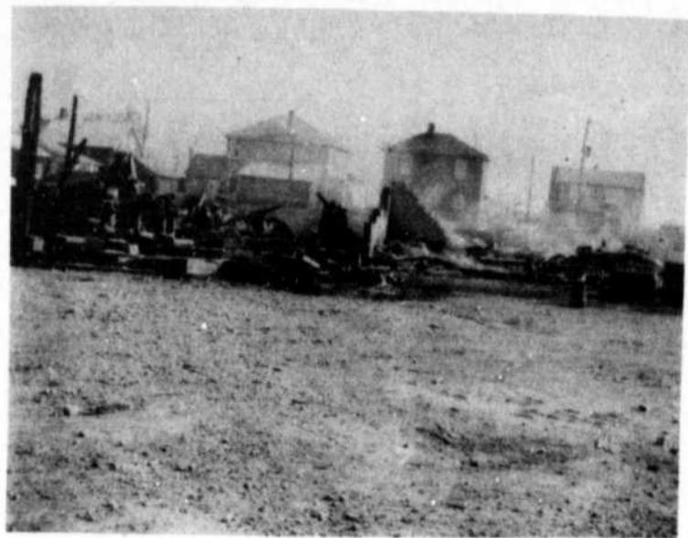
Sur la photo nous pouvons remarquer la destruction complète de l'usine Mineault par l'incendie.
