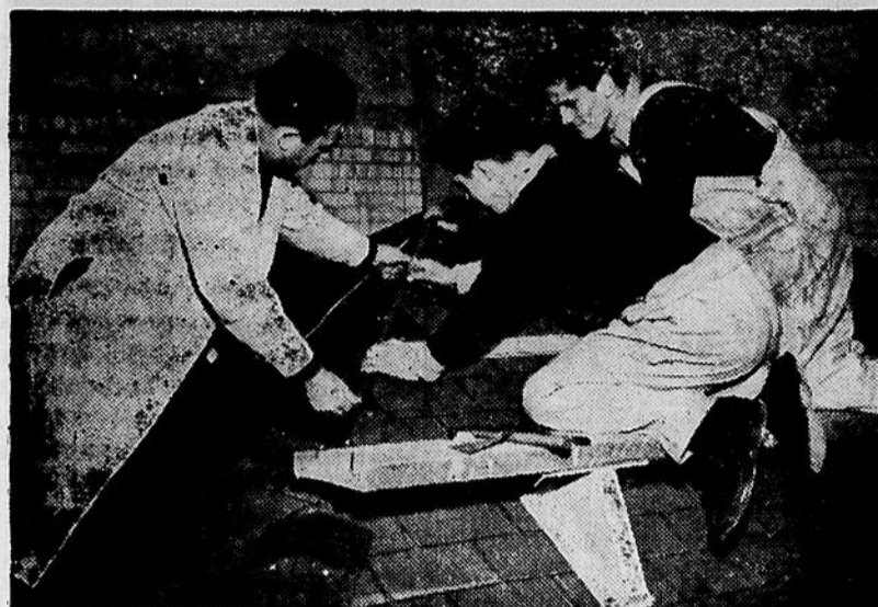
Toit qui coule, maison qui croule. Les élèves de cette école des métiers de la construction apprennent à effectuer la pose des bardeaux d'asphalte de la toiture selon toutes les précisions requises, de manière à ne pas perdre aucun des avantages de ce matériau à toiture très en usage.
