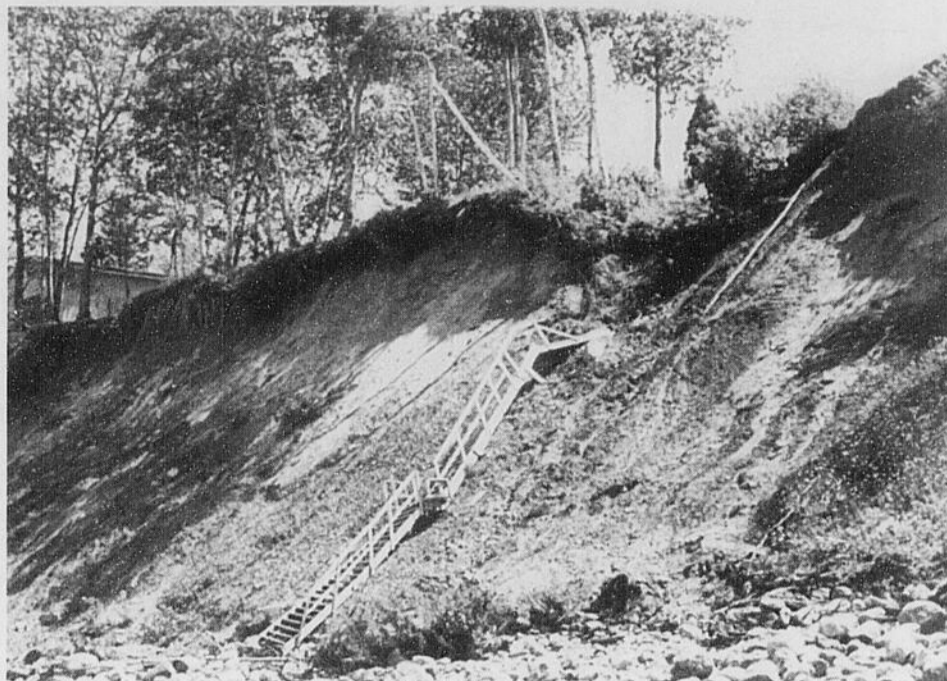
EMPLACEMENT - Cette scène donne un autre aperçu des dommages causés par l'érosion du terrain, dans le secteur des Battures (Vieux Chemin). (Photo Sylvain Dufour)
