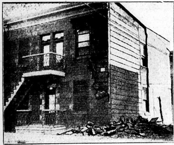
Photographie du mur qui s'est écroulé, hier après-midi, à l'angle de la rue Chapleau et Mont-Royal. On voit dans le bas un amas de briques qui se sont effondrées. (Photo "La Patrie").
