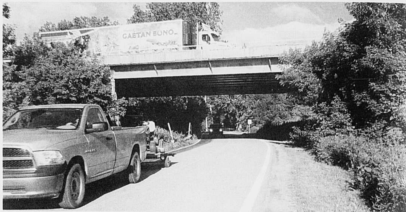
Une partie de l'un des deux viaducs surplombant le rang Bayonne-Nord, qui sera fermé durant 30 mois à compter d'avril 2014.
