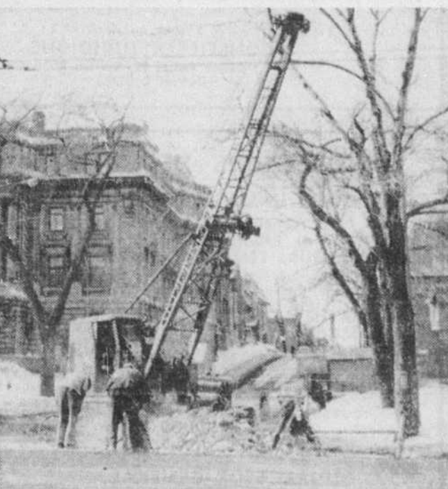
La rue St-Hubert est fermée pour plusieurs semaines. Déjà hier, les employés de la cité ont entrepris d'y poser une conduite d'égouts, après quoi ils élargiront la rue. (Photo Le Devoir)
