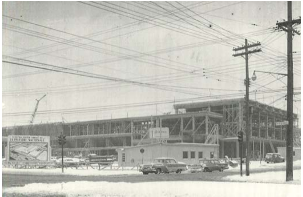
La construction de la Palestre nationale, devenue le Centre Paul-Sauvé, en 1960.
