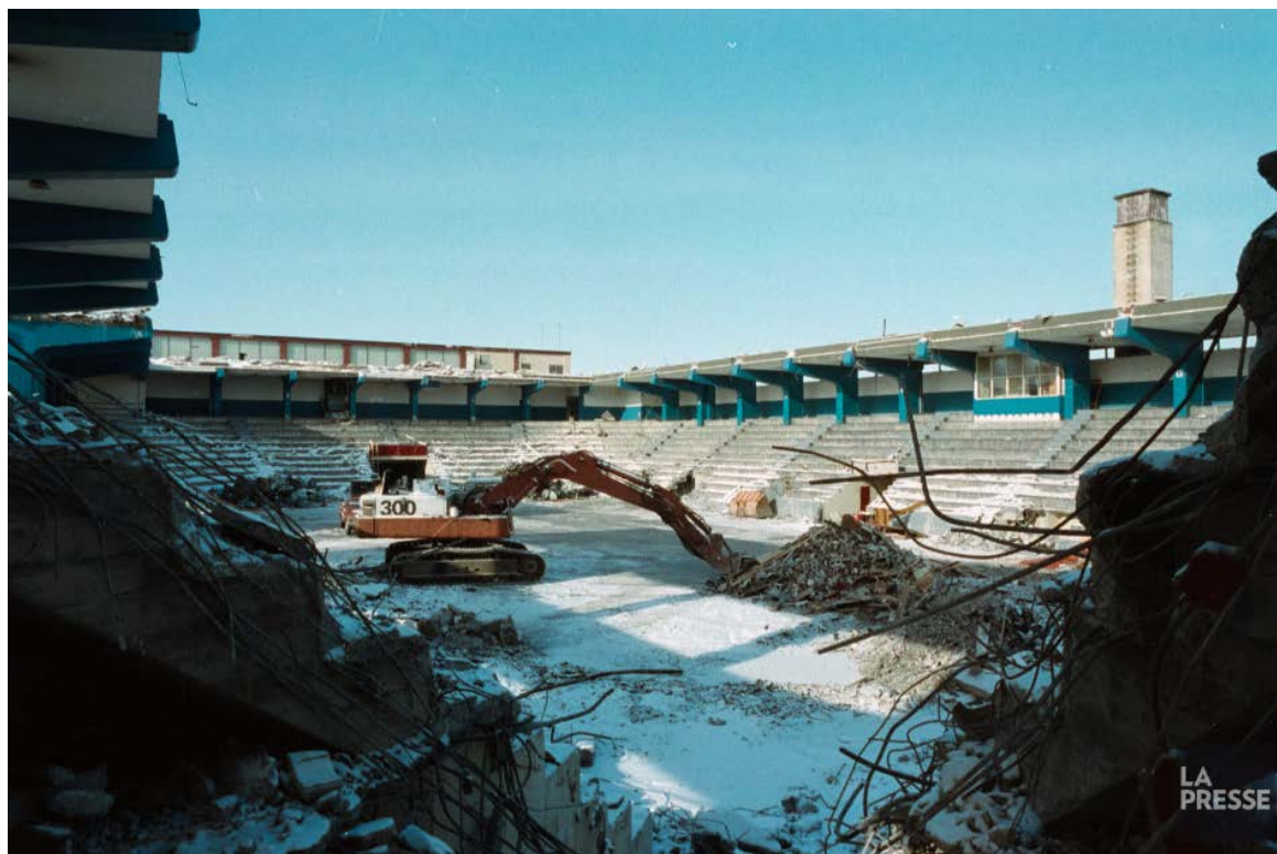
La démolition du Centre Paul-Sauvé, en janvier 1993. Source : BANQ, Fonds La Presse
