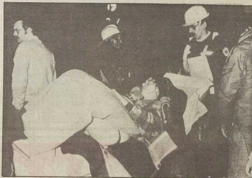
Des secouristes transportent sur une civière une des rescapés du navire "Herald of Free Enterprise".
