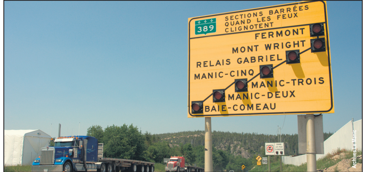
Des travaux sur certains segments prioritaires de la 389 ont déjà été réalisés dans le cadre du Programme d'amélioration de la route 389 du MTMÉ, même si la plupart des projets en sont encore globalement à l'étape des autorisations environnementales.
