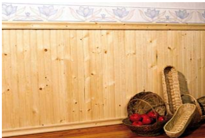
Figure 2 : Exemple d'un lambris d'appui ( Wainscot )
