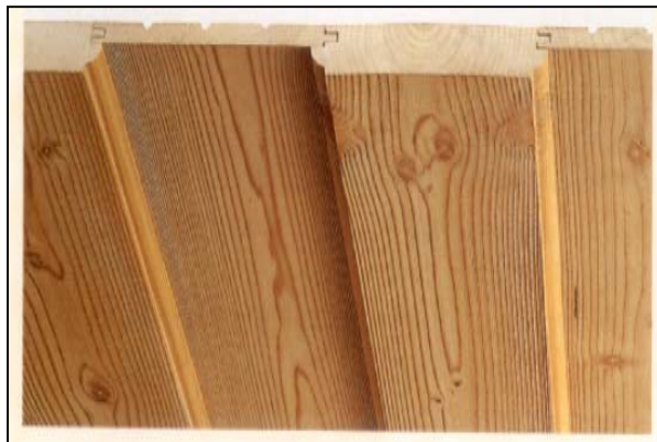
Figure 1 : Vue plongeante de lames de lambris en bois massif avec rainure et languette 5
