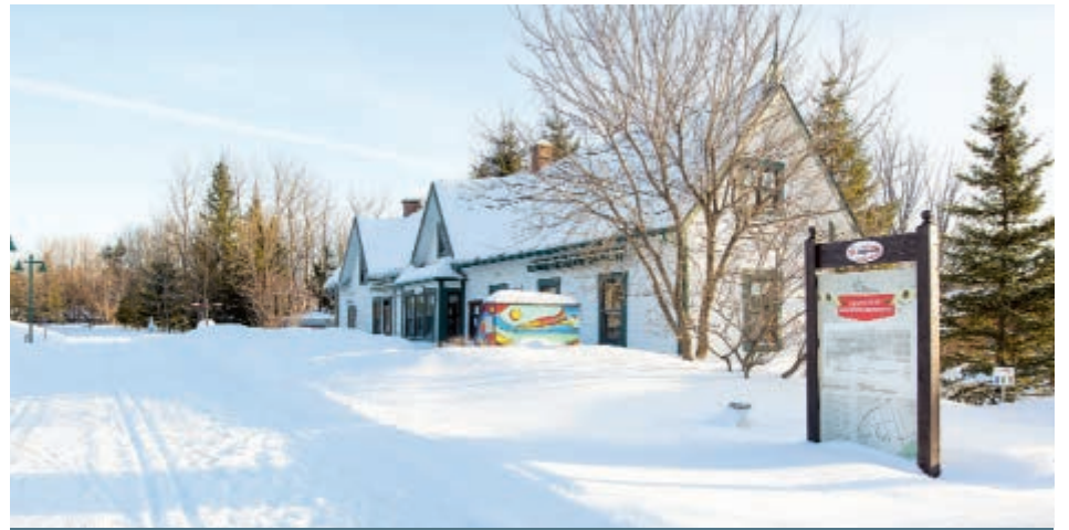
La gare de Prévost est appelée à devenir une maison d'accueil du P'tit Train du Nord.
