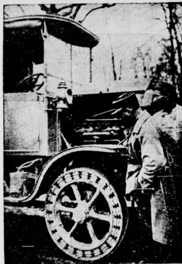
Les Allemands durent avoir recours à beaucoup "d'ersatz" durant la guerre de 1914-18. Ainsi quand le caoutchouc leur manqua, ils fabriquèrent des pneus d'automobiles constitués par des ressorts.
