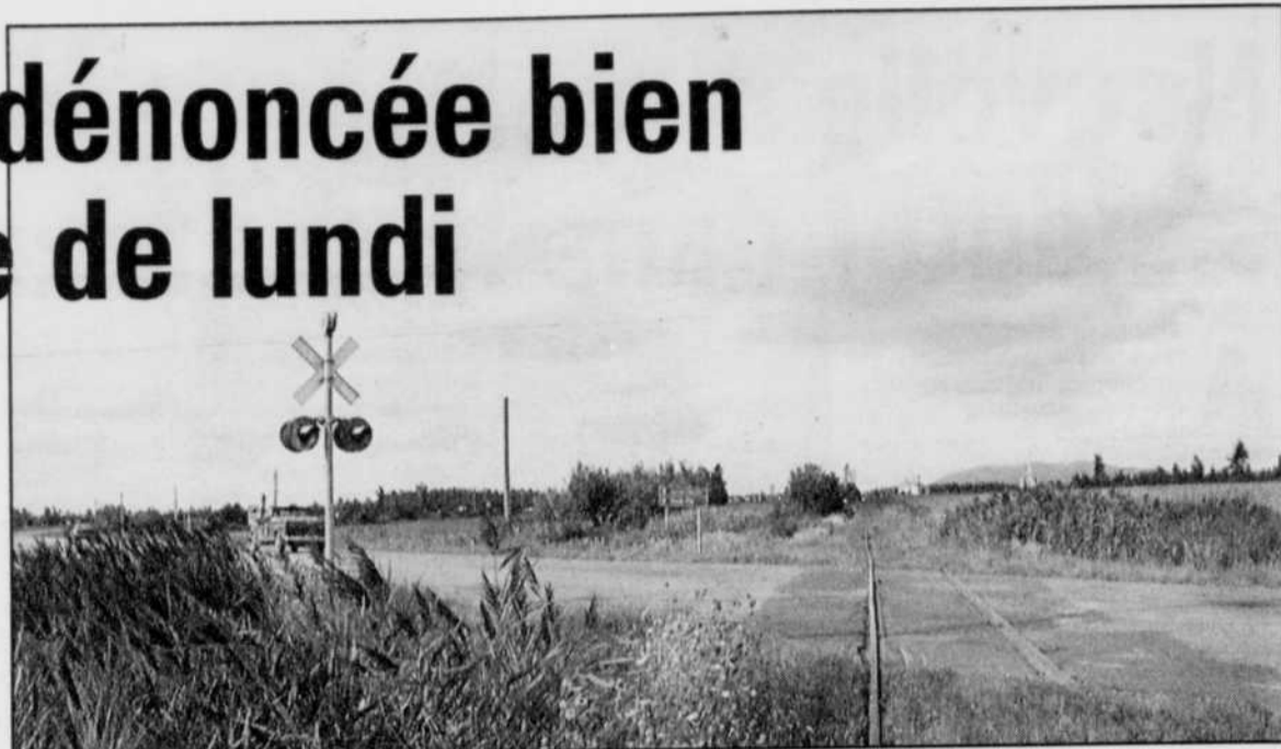
Yvan Paquin décrie depuis longtemps la faiblesse de la signalisation aux abords de la voie ferrée. La tragédie de cette semaine a malheureusement confirmé ses appréhensions.
