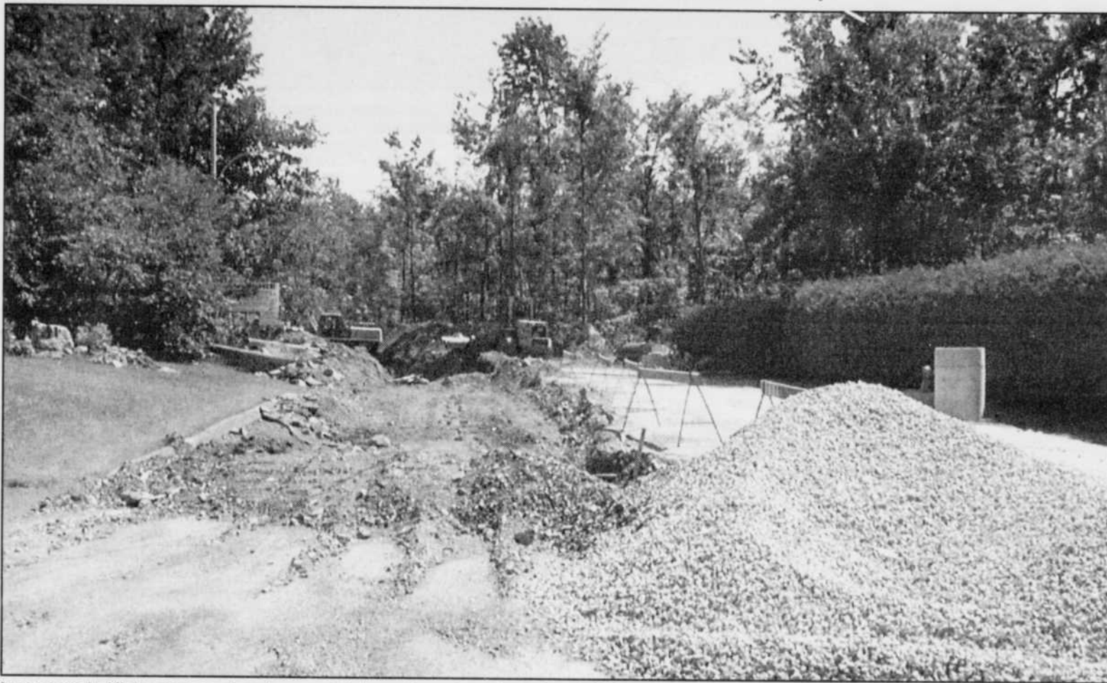
Les travaux de déboisement pour le prolongement de la rue Bourget vont bon train et la Ville pourrait profiter de l'occasion pour ouvrir une nouvelle rue dans ce secteur et y aménager de nouveaux lots.
