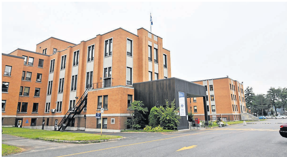
C'est sur les terrains des résidences Cooke et Roland-Leclerc que sera construite la future Maison Martin-Matte de Trois-Rivières. — PHOTO D'ARCHIVES: ÉMILIE O'CONNOR
