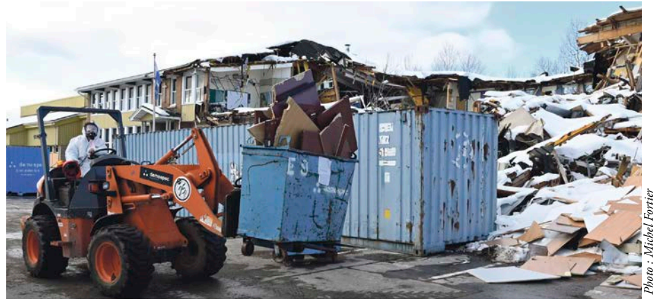
Les travaux de nettoyage sont commencés à l'école Val-des-Monts avec les précautions d'usage
