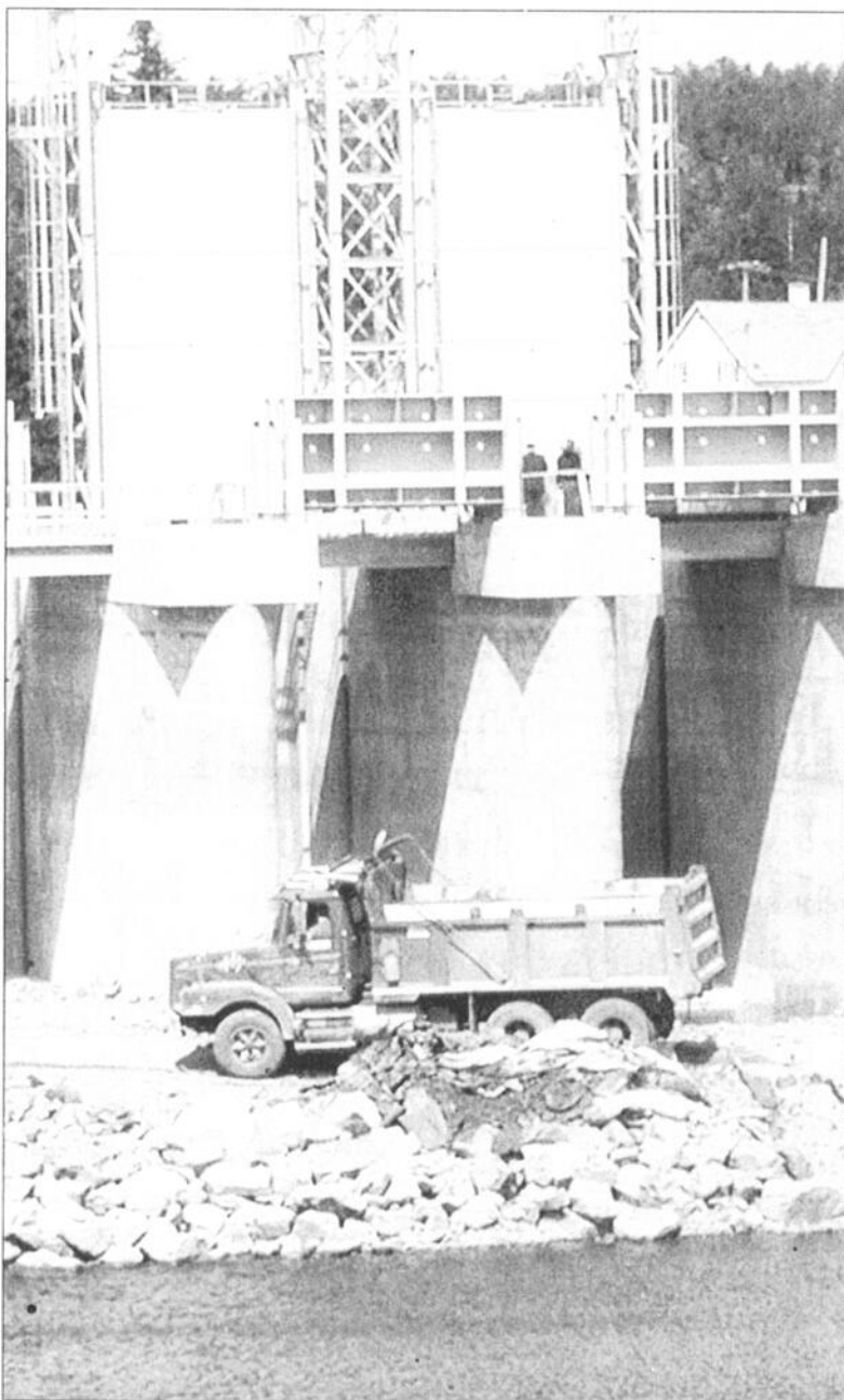
TRAVAUX - Hydro-Québec a effectué d'importants travaux de reconstruction des barrages de Pont-Arnaud (photo) et de Chute Garneau détruits lors du déluge de 1996.
