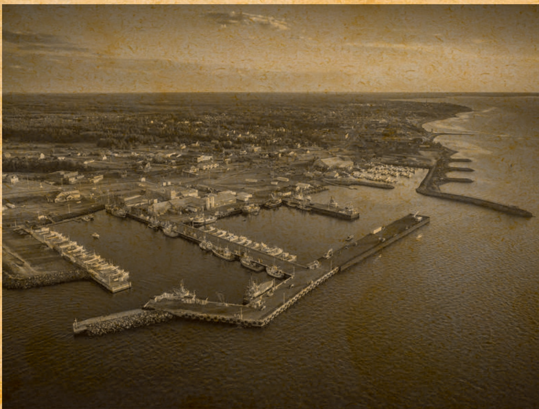
Photo aérienne - Quai, halte nautique et Carrefour de la Mer
