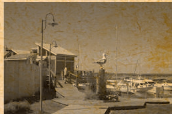
Site du Carrefour de la Mer et la halte nautique
