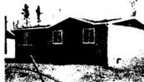
Construite en 1976. Bois et pierre. 5 1/2 pièces. Chauffage électrique. 358 rue Emile
