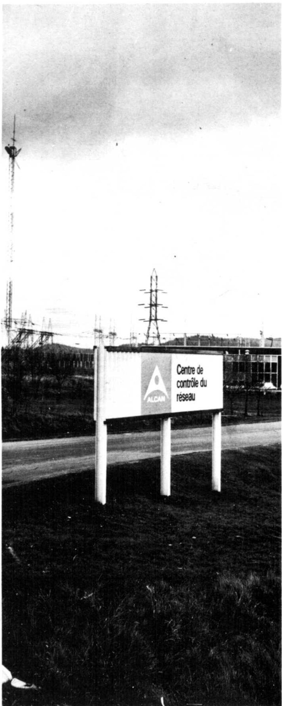
CONSTRUIT en 1961, l'édifice du Centre de contrôle du réseau loge également le bureau et l'atelier du Service des communications et de la protection. A gauche, se trouve l'antenne du réseau de communication du Centre de contrôle; et, à l'arrière, le poste de sectionnement où arrive la ligne de transport d'énergie qui vient de Chute-des-Passes.
