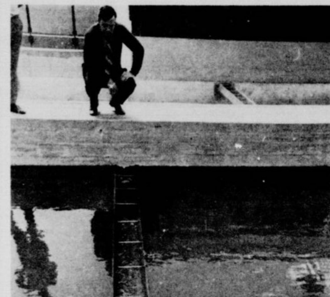
M. Yvon LeRouzès, ingénieur du service des travaux publics de Montréal, vérifie l'égouttement de l'eau purifiée, pendant la sédimentation, dans des augets qui conduisent l'eau vers la chloration.
