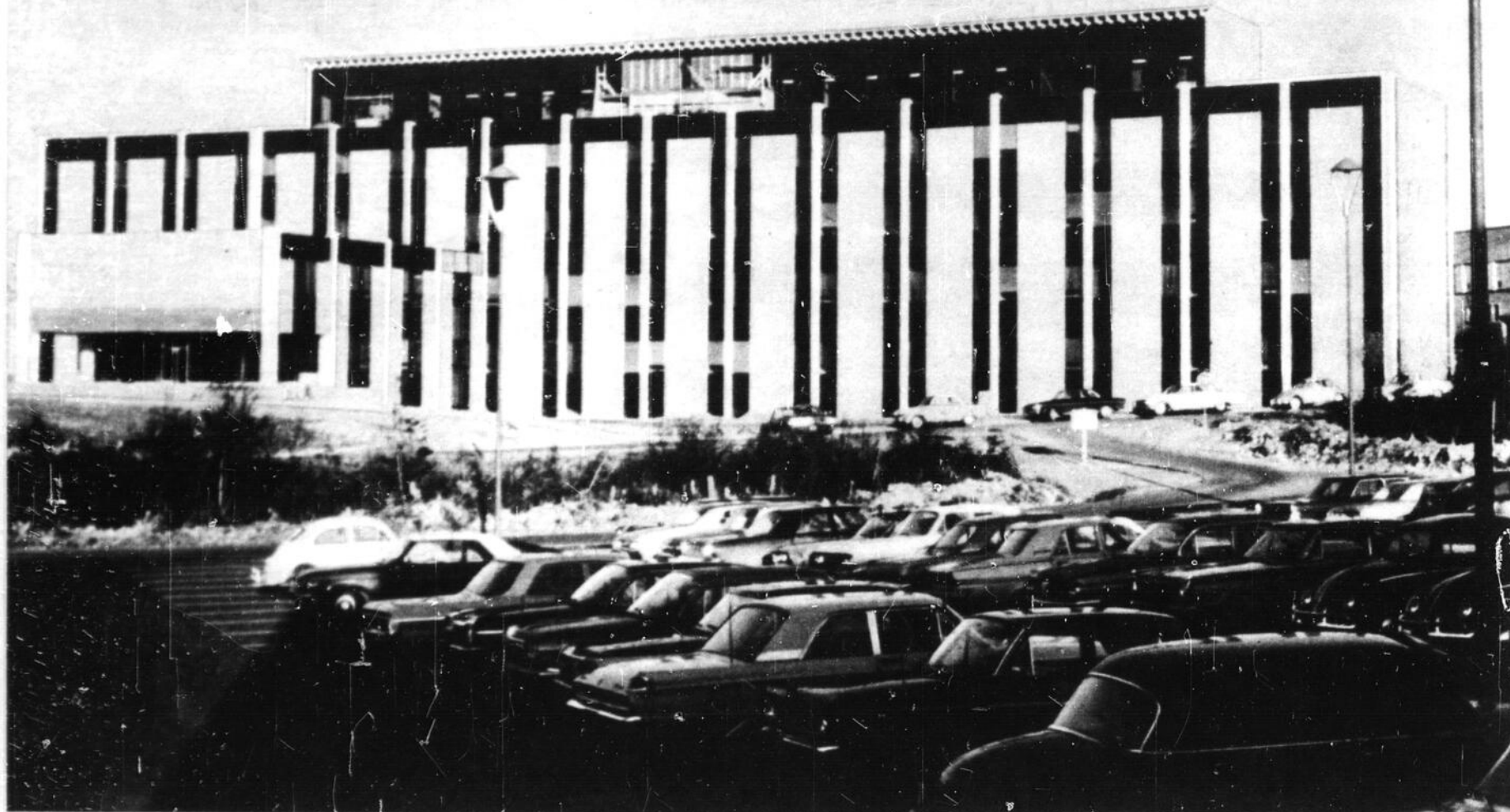
L'université de Terre-Neuve compte près de 5 000 élèves et des bâtiments sont en construction pour en loger davantage.
