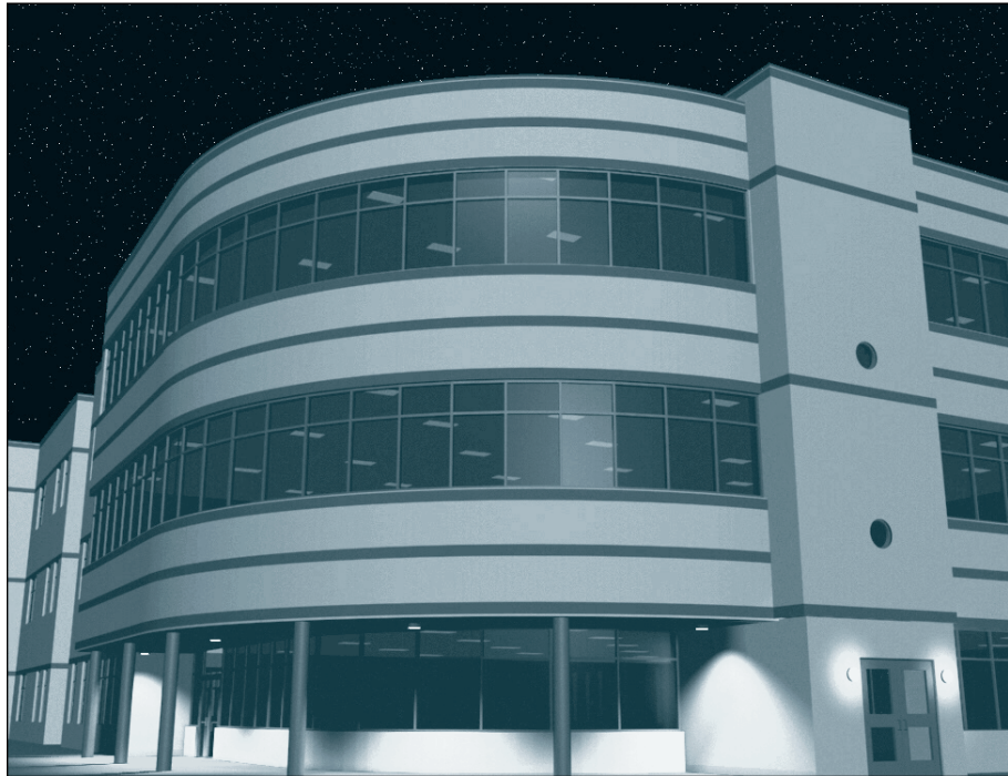
Structure d'acier, revêtement de maçonnerie, fenestration abondante, telles sont les caractéristiques architecturales du centre multiservice de Sainte-Thérèse
