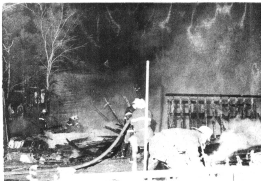
Deux adolescents de 13 et 14 ans, évadés de l'Hôpital Douglas du Boul. Lesallé à Verdun ont avoué être les auteurs d'un incendie qui a ravagé de fond en comble un immeuble de logements en construction au 230 de la rue Verchères dimanche dernier à Longueuil. Le feu a pris naissance à 21 heures et a nécessité une alarme générale. Les deux adolescents devaient comparaître à la Cour du Bien-Être Social à Montréal lundi dernier.
