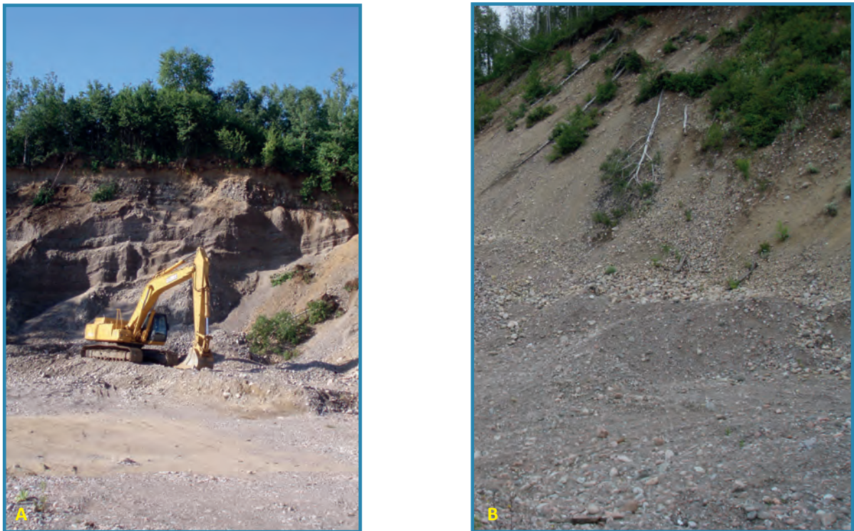
Photo 25 – (A) Site 431 visité en 2007. Il expose des faces de 8 à 10 m de hauteur formées de lits de gravier alternant avec des lits de sable moyen à grossier. (B) Lors de notre visite en 2019, les faces étaient effondrées (site 431, 32A08).
