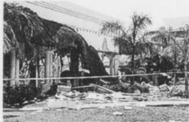
PHOTO ARCHIVES ASSOCIATED PRESS L'explosion du Grand Riviera Princess Hotel, situé à Playa del Carmen au Mexique, aurait été causée par une fuite dans le tuyau de gaz de chauffage, enflammée par une étincelle.
