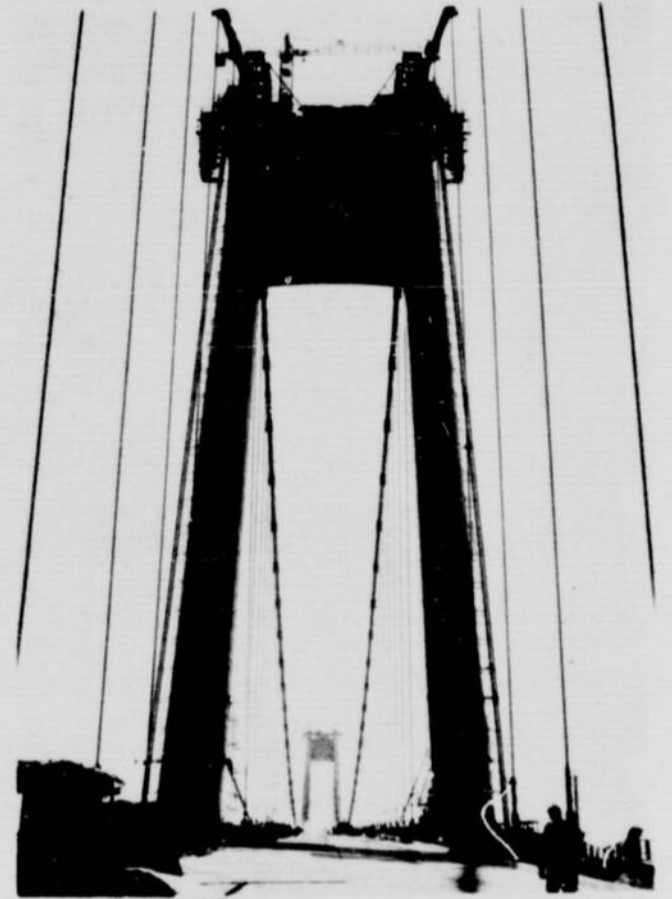
Vu de face. Les câbles soutiennent une pesant deux fois plus grande que celle de la tour Eiffel. La largeur de la principale travée est de 39 pieds, soit un espace suffisant pour laisser passer près de deux mille voitures à l'heure.
