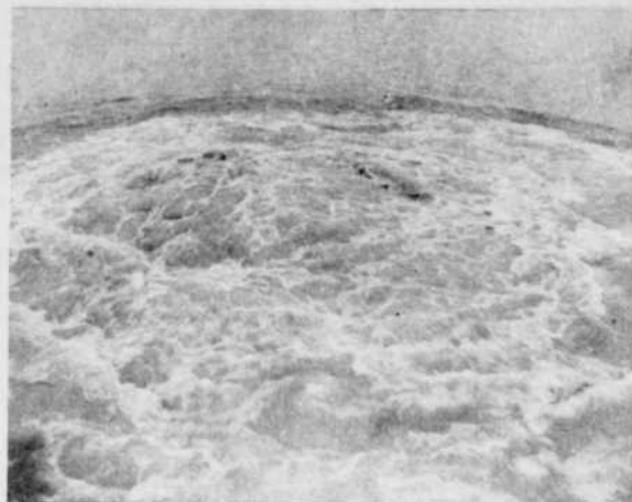
Les bulles de gaz qui crèvent à la surface sont le seul indice de cette opération de sautage sous l'eau pour laquelle on a fait usage de la technique à retard fractionné.
