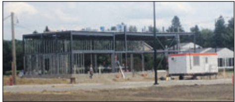
Les travaux sont actuellement arrêtés à cause des vacances dans le secteur de la construction.
