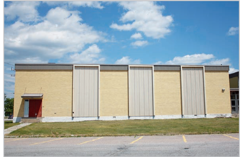
L'auditorium de la Polyvalente des Rivières fait partie des projets retenus dans le cadre de la mesure Amélioration, maintien et transformation.
